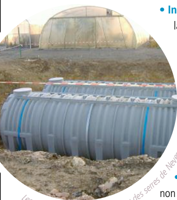
Les cuves de récupération de l'eau des serres de Nevers © Ville de Nevers
