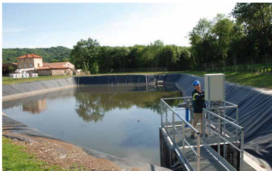
Vue du bassin d'orage ouest : situés dans une partie boisée de l'usine, les abords immédiats du bassin d'orage ouest ont fait l'objet d'un reboisement.
