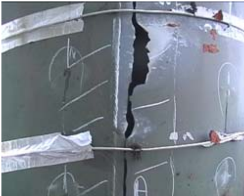
Erosion d'un cyclone
