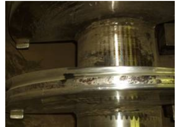
Erosion d'une pale d'un sécheur indirect
