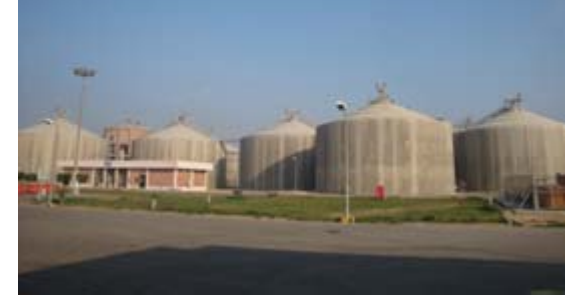
GABAL – Le Caire 100.000 m3 de digesteurs
