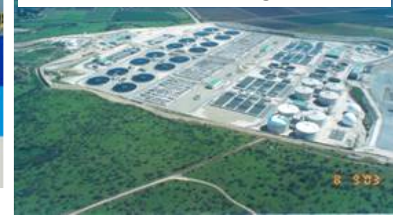
LA FARFANA - Chili 120.000 m3 de digesteurs
