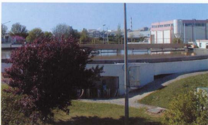
La station d'épuration de la communauté d'agglomération de la Rochelle
