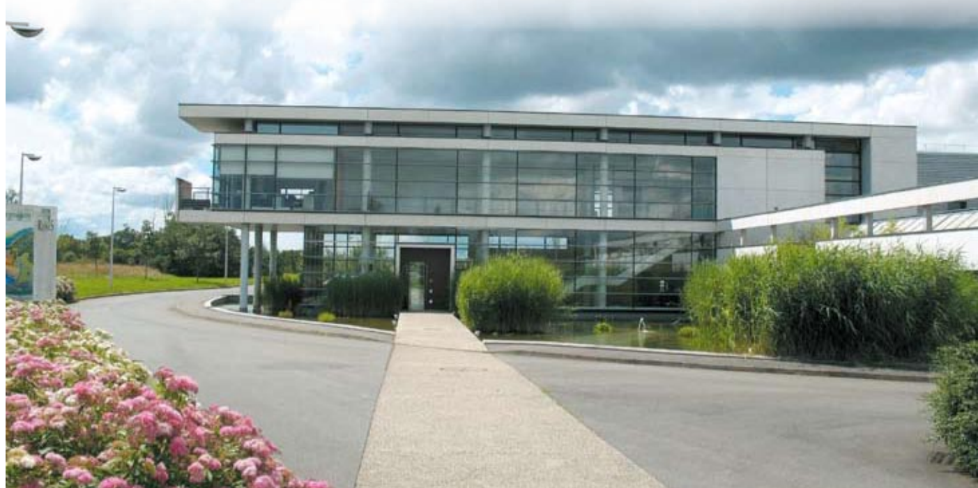
La station d'épuration de Beaurade (360 000 équivalents-habitants) est certifiée ISO 14001. La Ville de Rennes veut étendre cette certification à l'ensemble de son réseau d'assainissement.
