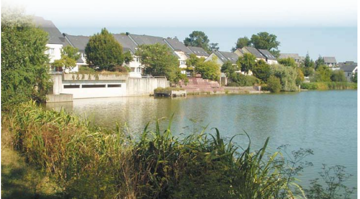
Rennes a entrepris un important programme de travaux pour améliorer l'efficacité de ses bassins et déversoirs d'orage ; ici celui de Longchamp.
