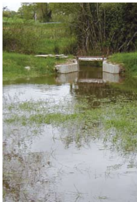
L'ouvrage de retenue des eaux hivernales
