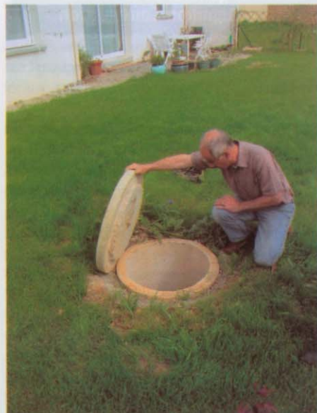
Dans le lotissement « Les Vergers II » ont été prévues des citermes qui recueillent l'eau de pluie, ensuite utilisée pour l'arrosage et les W.-C.
