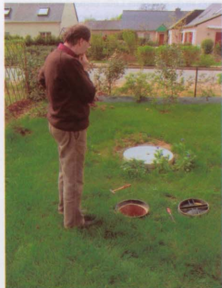
Dans le lotissement « Les Vergers II » ont été prévues des citermes qui recueillent l'eau de pluie, ensuite utilisée pour l'arrosage et les W.-C.
